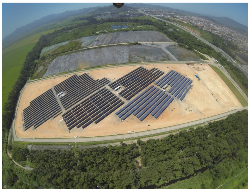
Figura 42 - Usina em Tubarão, no sul de Santa Catarina, tem 19.424 painéis solares - capacidade instalada de 3MWp – 10 hectares. Fonte: http://www.cdl-bc.com.br/portal/noticias/maior-usina-solar-do-pais-entra-em-operacao-em-sc/
