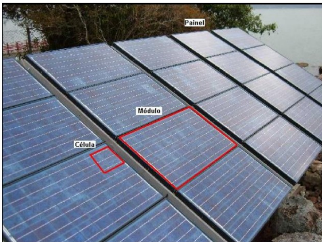
Figura 36 - Diferença entre célula, módulo e painel fotovoltaico. Fonte: http://repositorio.roca.utfpr.edu.br/jspui/bitstream/1/3064/1/CT_COELE_2014_1_08.pdf
