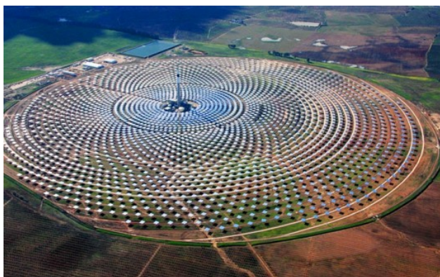
Figura 34 - Exemplo de uma usina solar - Gemasolar - Espanha. Fonte: http://www.manutencaoesuprimentos.com.br/imagens/primeira-usina-de-energia-solar-24-horas-ja-esta-funcionando.jpg
