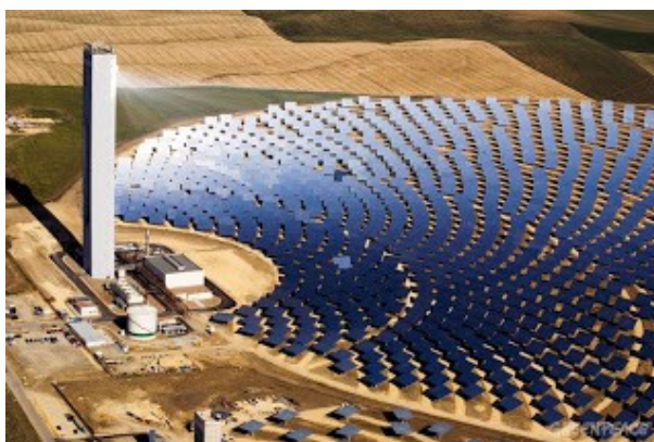
Figura 30 - Modelo de uma usina termossolar. Fonte: http://2.bp.blogspot.com/-eCDL95P_LbE/UTK-v9HyP1/AAAAAAAAAMU/o9UsTrXPda8/s320/Energ%C3%ADa-solar-t%C3%A9rmica+02.jpg
